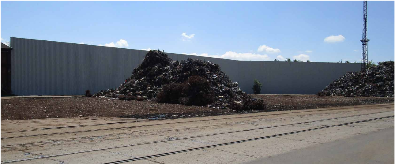
Errichtete Schallschutzwand am Schrottlager 4/5 (2016)
