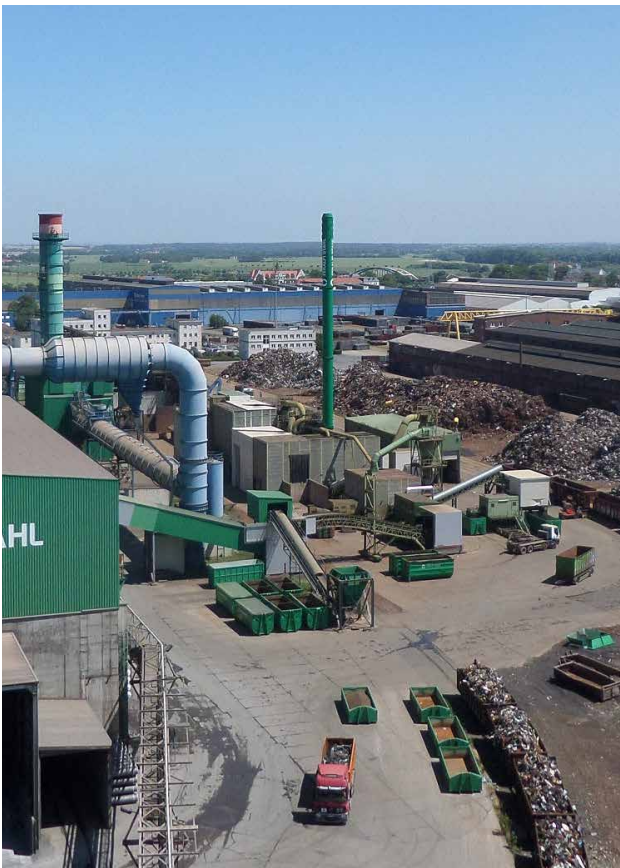
Einhausungen, Kapselungen und Emissionsminderungsmaßnahmen am Kondirator (2014–2016)
