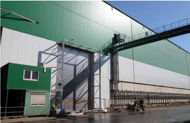
Weitere Schließung der Schrotthalle, Südseite (seit 2015)
