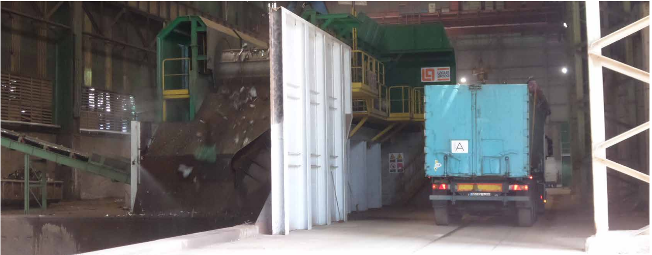
Schrottreinigungsanlage / Magnettrommel (seit 2015)
