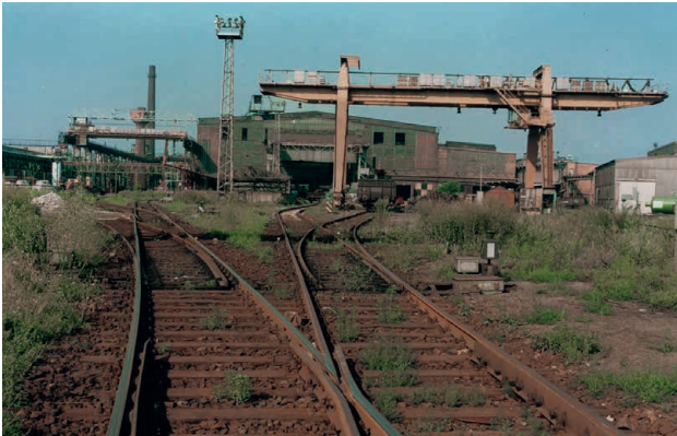
Blick auf das Gelände des ehemaligen Martinwerkes II (heutiges ESF-Gelände) zum Zeitpunkt des teilweisen Abbruchs der Werksanlagen (Foto: Helmut Neumann 24.07.1992)
