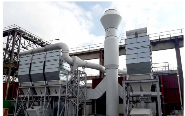
Neue Einhausung für Kippprozess Saugfahrzeuge / Kehrmaschinen (links) inkl. Absaugung und Entstaubungsanlage im Fallwerk (rechts)
