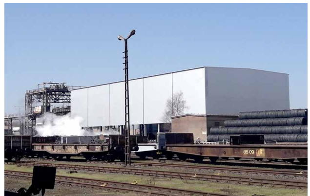
Neue Einhausung für Kippprozess und Abkühlung E-Ovenschlacke
