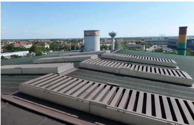
Austausch und Einbau von Zu- und Ablüftern im Dachbereich sowie in den Ost- und Westgiebel des Stahl- und Walzwerkes (seit 2014)
