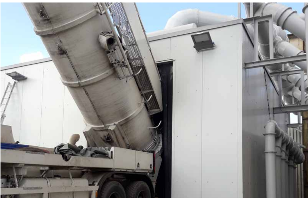
Neue Einhausung für Kippprozess Saugfahrzeuge / Kehrmaschinen (links) inkl. Absaugung und Entstaubungsanlage im Fallwerk (rechts)
