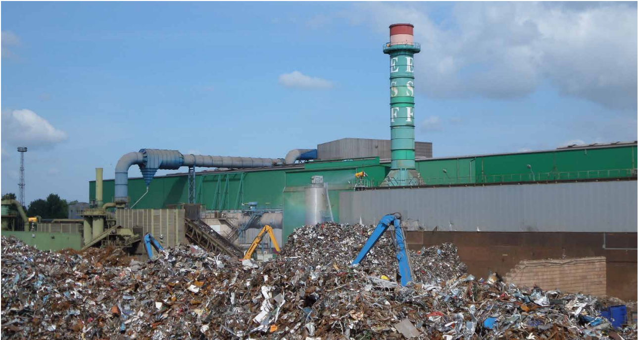
Darstellung der zweiten Entstaubungsanlage (seit 2006) mit Sammelleitung, Horizontalzyklon, Filterhaus, Kamin und Staubsilo, im Vordergrund die Kondiratoranlage
